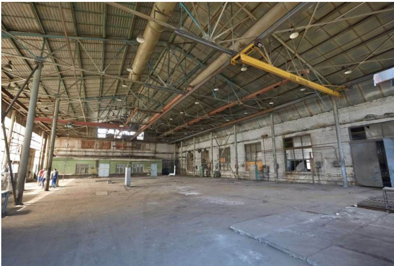
Производственный цех с кран-балкой
